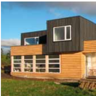
Instalación vertical como revestimiento
