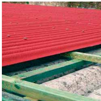
Instalación sobre cubierta existente
